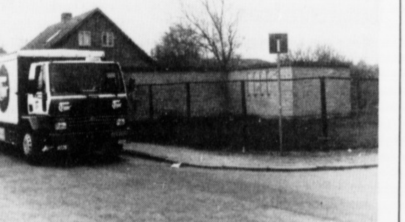
Dagnæs Syd Vandværk på Lupinvej har problemer med rust i vandet. Nu er det godkendt, at værket køber et trykfilter. (Arkivfoto)
